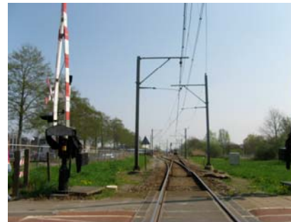
Spoor aan de noordzijde
